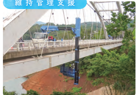
主要地方道京都日吉美山線中大橋 (南丹市内)
