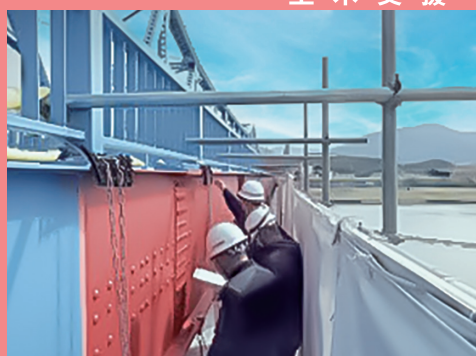
国道477号 大堰橋 (南丹市内)
