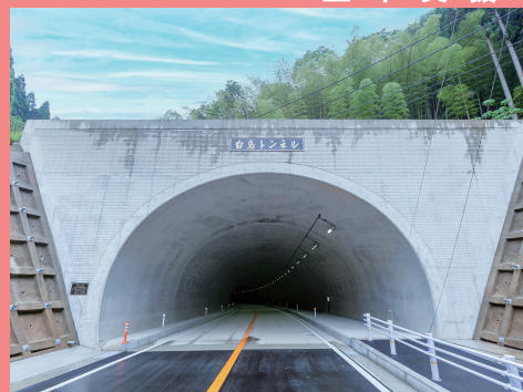
主要地方道小倉西舞鶴線 白鳥トンネル (舞鶴市内)
